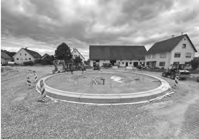
Fertiggestellter Innenring des Kreisverkehrsplatzes
