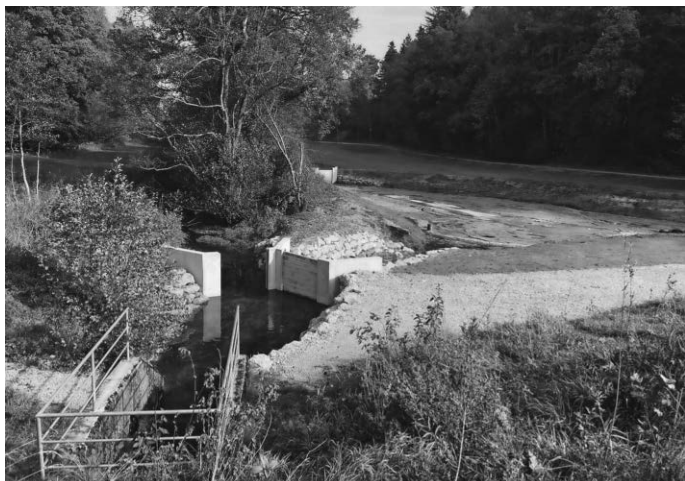
Auslauf des Reichenbach Weihers mit Verteilerbauwerk und Absetzbecken
