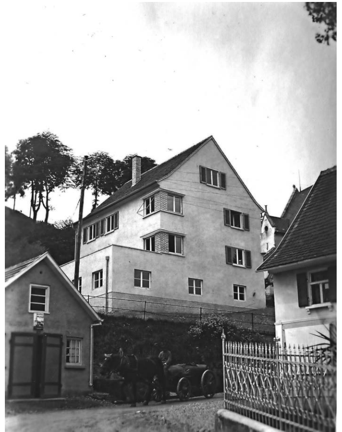
Blick vom Alten Rathausplatz auf das noch aktive Schwesternhaus-Gebäude
