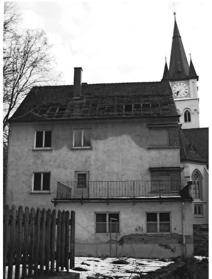
Das Schwesternhaus wurde im März 2006 abgebrochen
